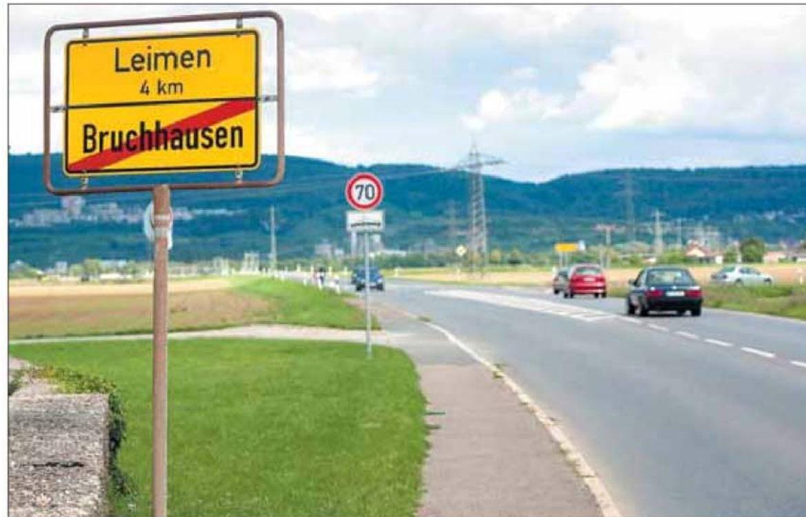
Im März stimmt der Petitionsausschuss über den Rückbau der L 600 zwischen Bruchhausen und dem Umspannwerk ab. Foto: Alex
