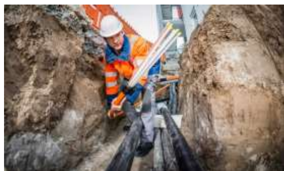
Verlegung von Leerrohren für den Breitbandausbau
